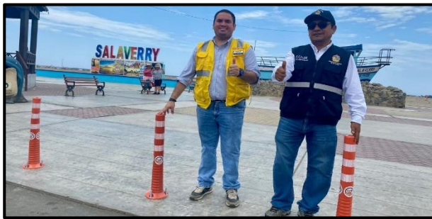
Foto 3. Entrega y colocación de bolardos en el ingreso a la Alameda 24 de octubre
